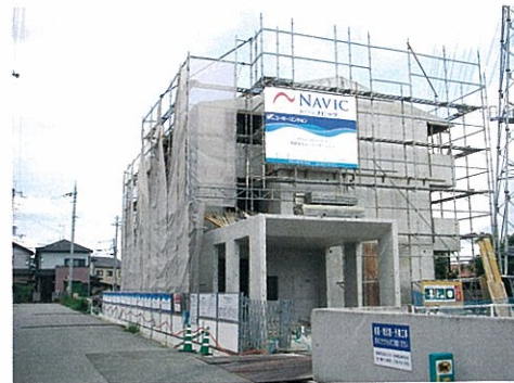
工事現場風景
